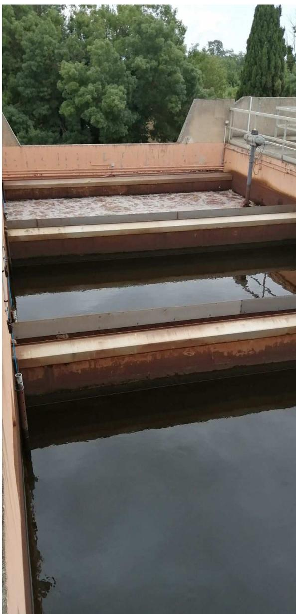
Les ouvrages de filtration présentent des fuites en divers endroits, voiles et planchers du Génie Civil : une étude de réfection des bétons et étanchéité devient nécessaire afin de limiter les pertes en eau des ouvrages.
