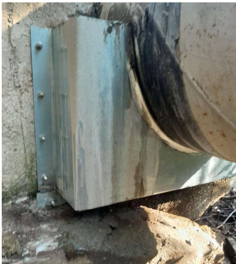
Coffrage métallique mis en place au niveau de la canalisation en 700 entre SCP et Gargalon
