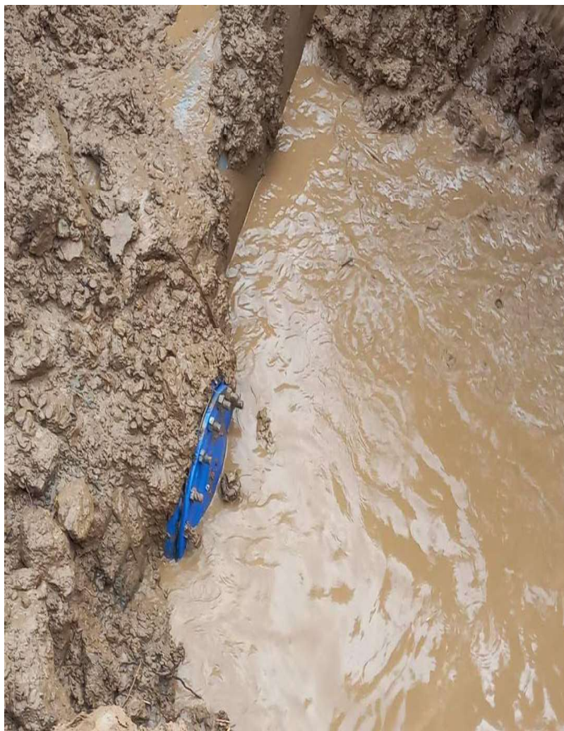
Plaque pleine mise en place pour isoler la fuite
